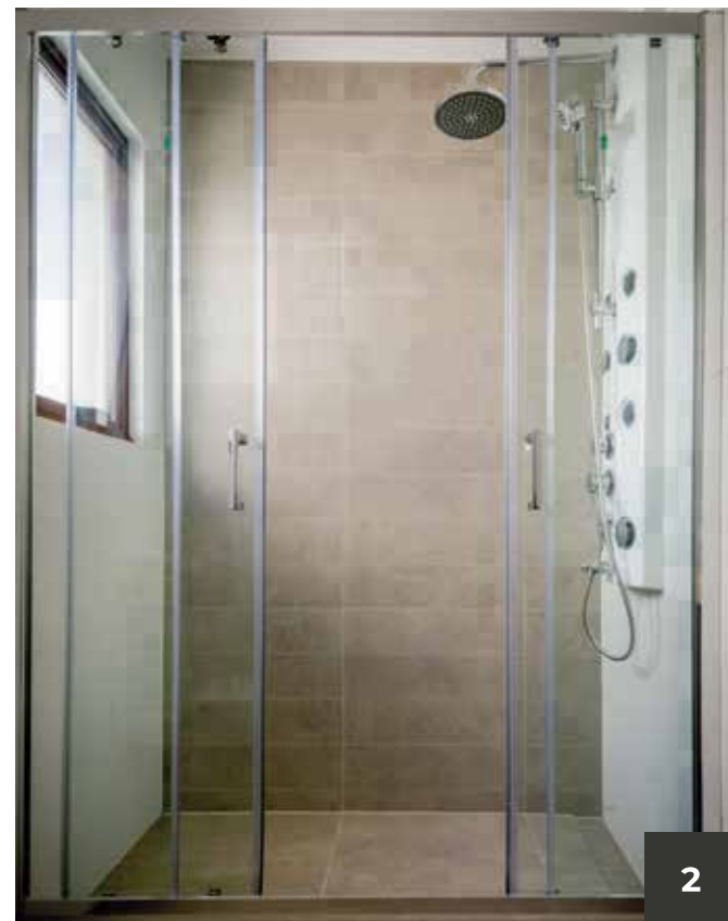
2. Baño principal con ducha en obra, mampara de vidrio y columna de hidromasaje
